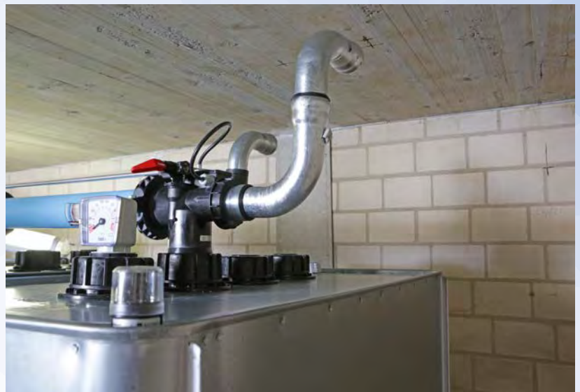
Die bauseitige Füllleitung wird durch Schellen gesichert.
