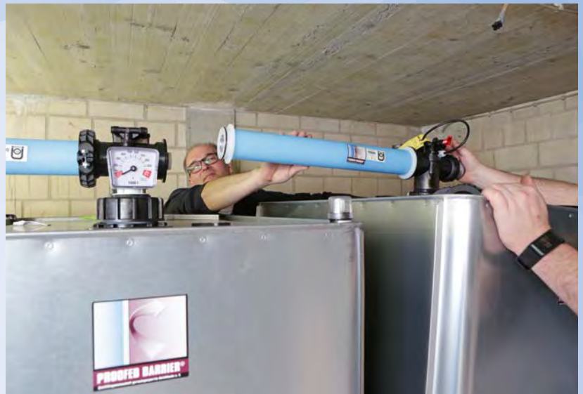
Das kombinierte Füll- und Lüftungsrohr lässt sich einfach montieren.
